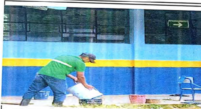
Foto 2: Pintura interior y exterior de escuela
