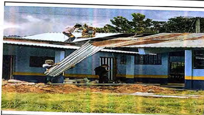
Foto 4: Sustitucion de Láminas
